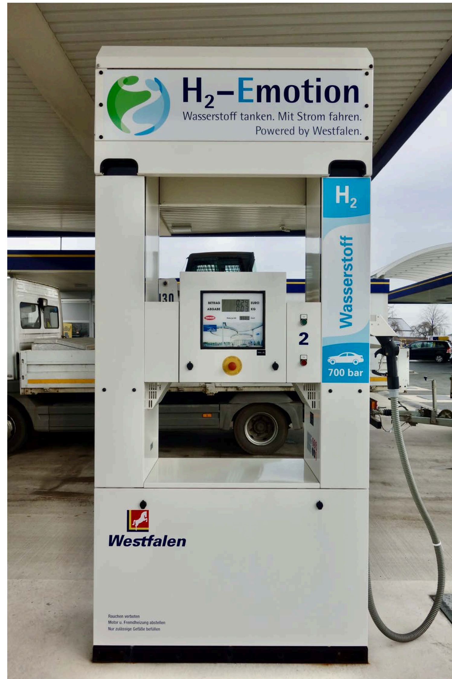
Wasserstofftankstellen errichten (© Westfalen AG)
