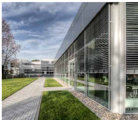
➤ In Steinfurt gibt es umfangreiche Umbau- und Modernisierungsarbeiten.
