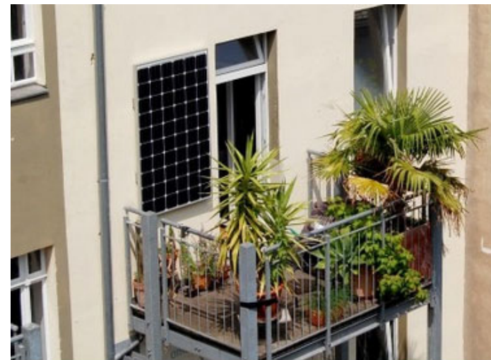
An der Hauswand
