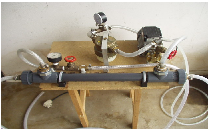
Abb. 2: Mikrofiltrationsanlage im Technikumsmaßstab. In der vorderen Röhre befindet sich die Hohlfasermembran mit einer Porenweite von 0,5 – 1,0 \mu\text{m} .
