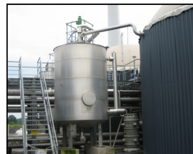
Bild 1: Hygienisierbehälter (12m 3 ) vor dem Fermenter
