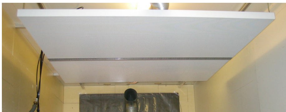
Kühlsegel mit integriertem Schlitzauslass
