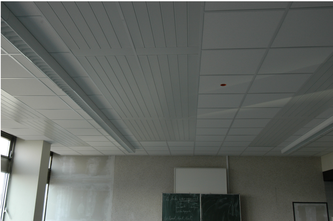
Fertig montierte Deckenheizung im Klassenraum
