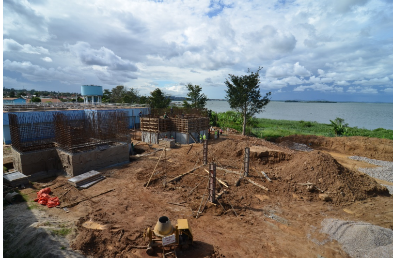
Abbildung 1: Bau zweier Reaktionskammern für Koagulation & Flockung
