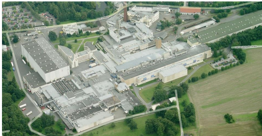
Abbildung 1: Luftansicht der Firma Schoeller in Osnabrück, Quelle: www.bing.com/maps
