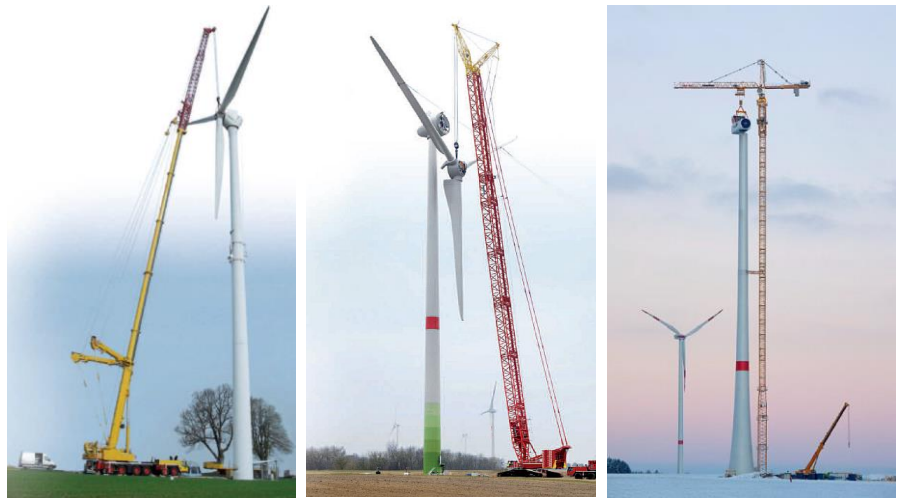
Abbildung 2: Anlagenmontage mit Mobil-, Raupen- und Turmkran
