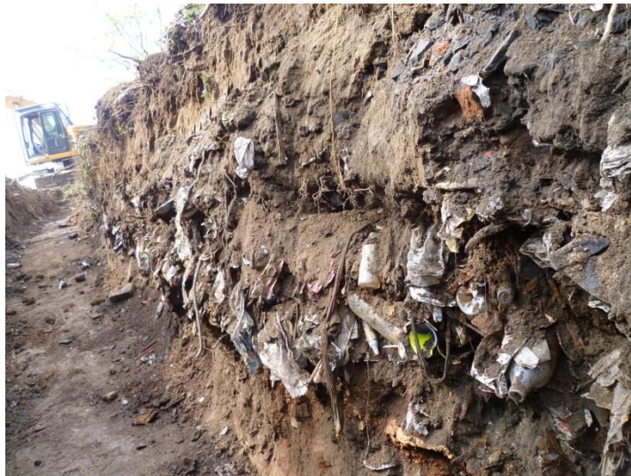
Abb. 4: Schichtenaufbau der Deponie zu sehen in einem Baggerschurf
