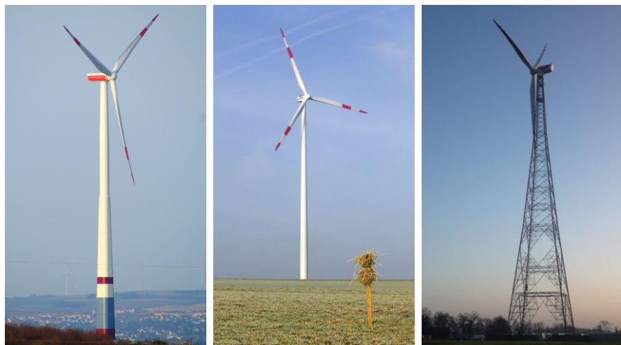
Abbildung 1: Hybrid-, Stahlrohr- und Stahlgitterturm im Vergleich
