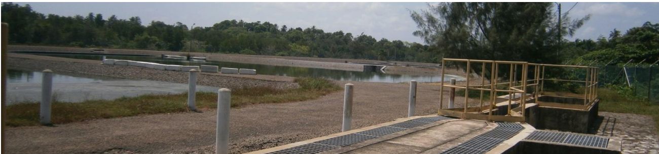
Abbildung 2: Abwasserteichsystem in Hikkaduwa
